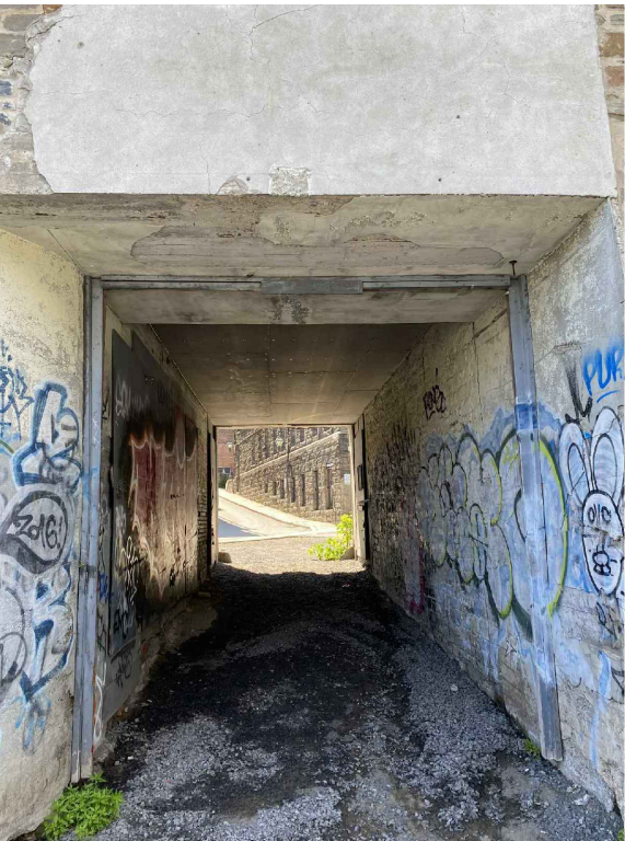
PHOTO 3. PORTAIL FAÇADE NORD
