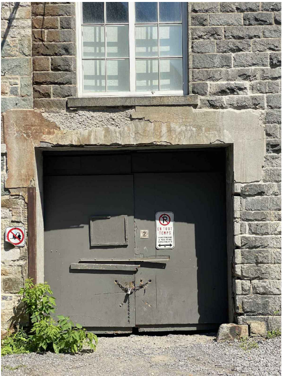
PHOTO 1. PORTAIL FAÇADE SUD
