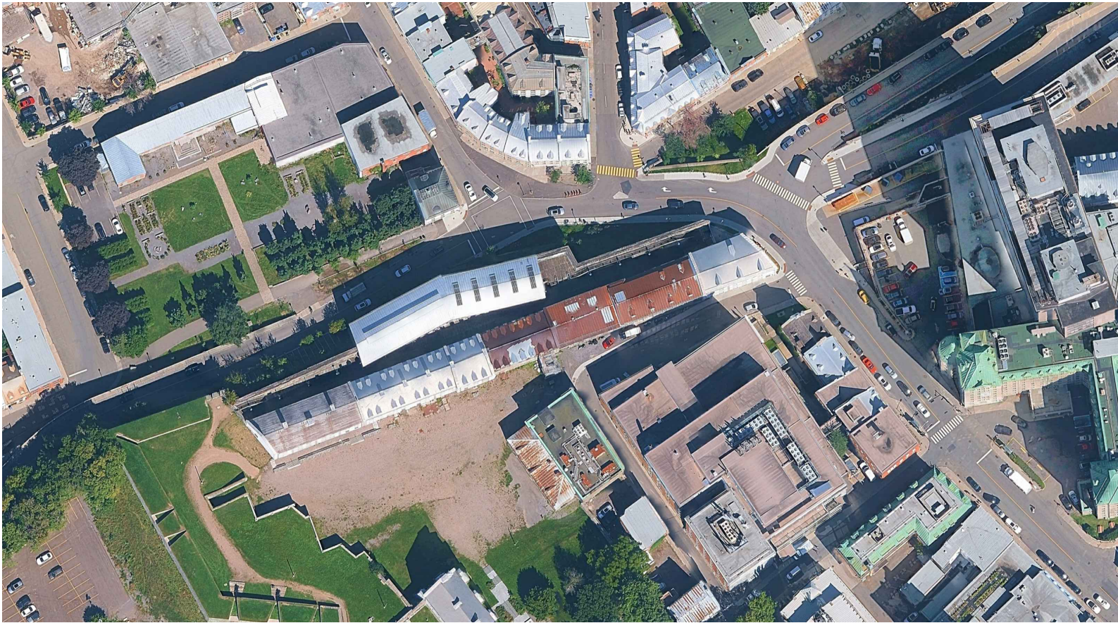
BÂTIMENT DES NOUVELLES-CASERNES. BLOC 5
