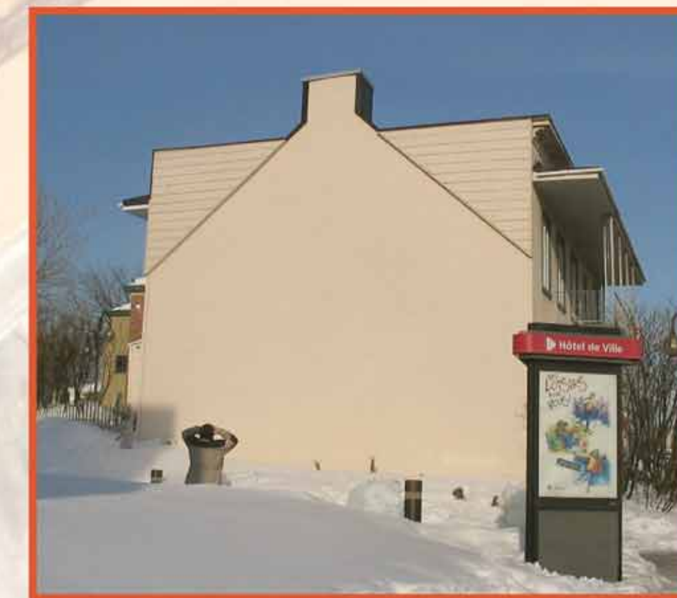
Le mur avant la réalisation
