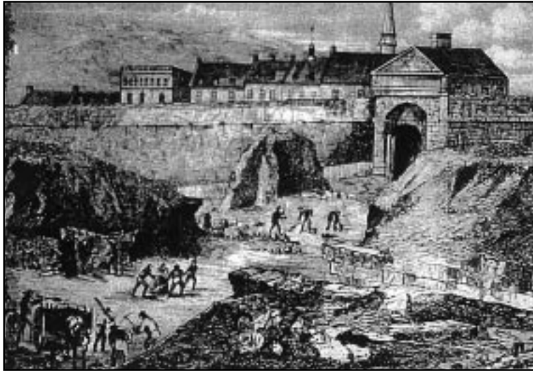
Figure 2 Le démantèlement des ouvrages avancés.
