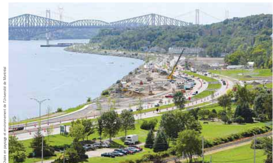
La promenade Samuel-De-Champlain en chantier : un premier pas dans la bonne direction.
